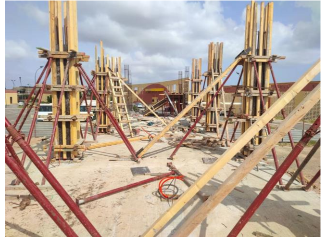
COFFRAGE POTEAUX 1 ER ETAGE BATIMENTS
