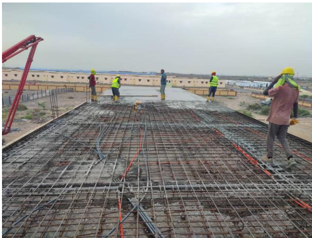
COFFRAGE ET FERRAILLAGE DALLAGE
