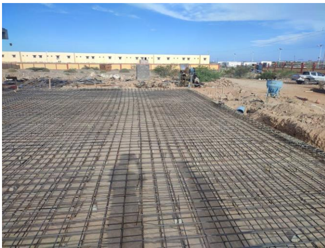
COFFRAGE ET FERRAILLAGE DALLAGE
