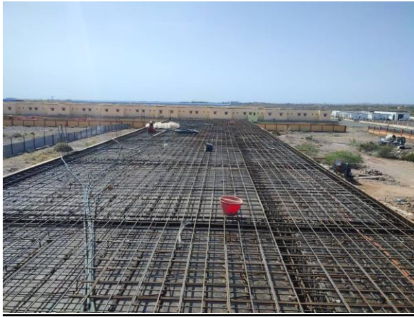
COFFRAGE ET FERRAILLAGE DALLE 1 ER ETGAE
