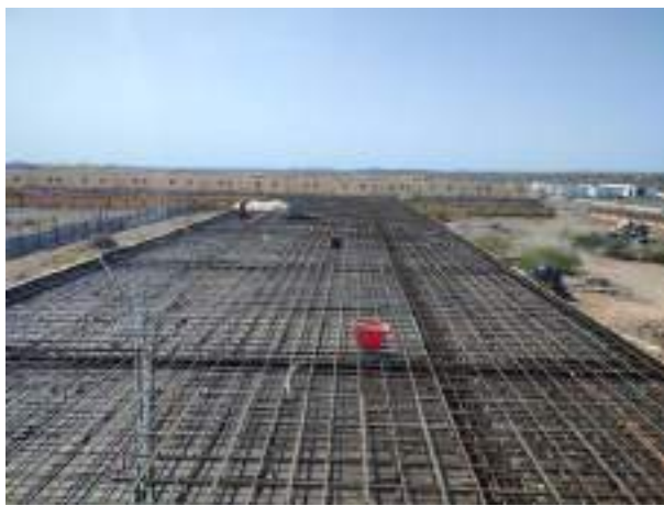
COFFRAGE ET FERRAILLAGE DALLE 1 ER ETGAE
