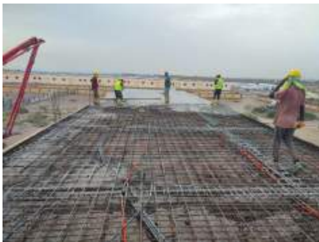
COFFRAGE ET FERRAILLAGE DALLAGE
