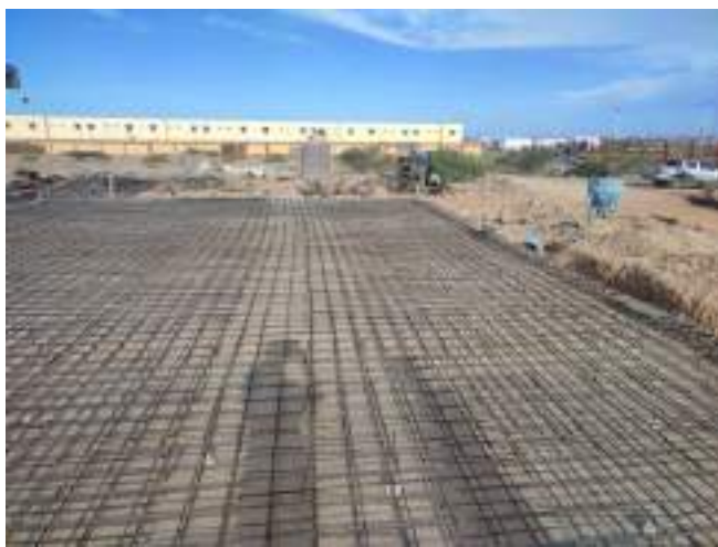
COFFRAGE ET FERRAILLAGE DALLAGE
