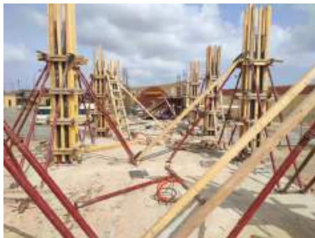
COFFRAGE POTEaux 1 ER ETAGE BATIMENTS
